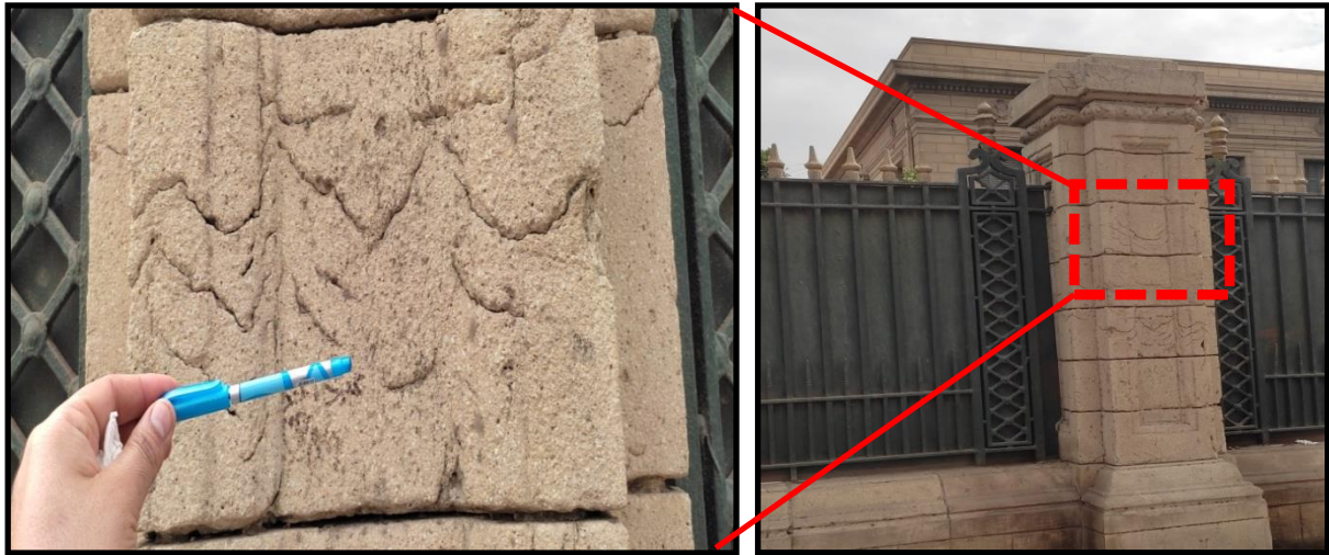
صوره (3) تأثير درجات الحرارة على تلف مواد البناء بالسور الخارجي لجامعة القاهرة الدراسة الميدانية: 2020/7/15 ناظراً صوب الجنوب الشرقي
